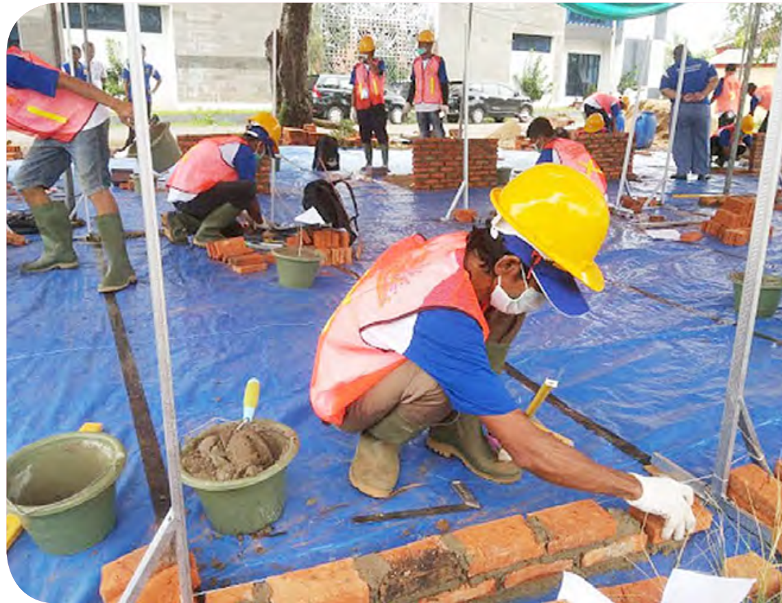
Pembangunan proyek tetap dengan protokol kesehatan
